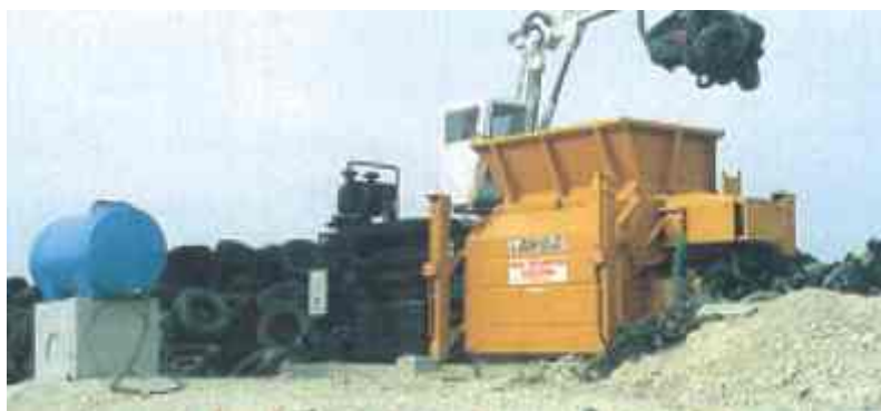
Figura 11 Impianto triturazione pneumatici
